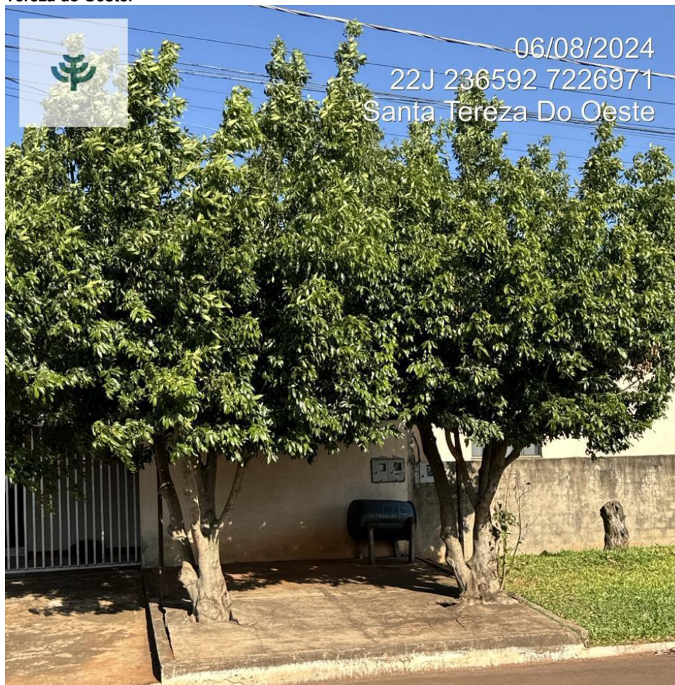
Figura 23 – Arborização em conflito com a calçada diagnosticada no município de Santa Tereza do Oeste.
