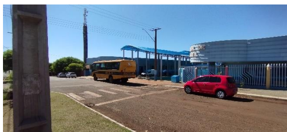
Figura 2.10. Acesso ao centro de Educação Infantil
