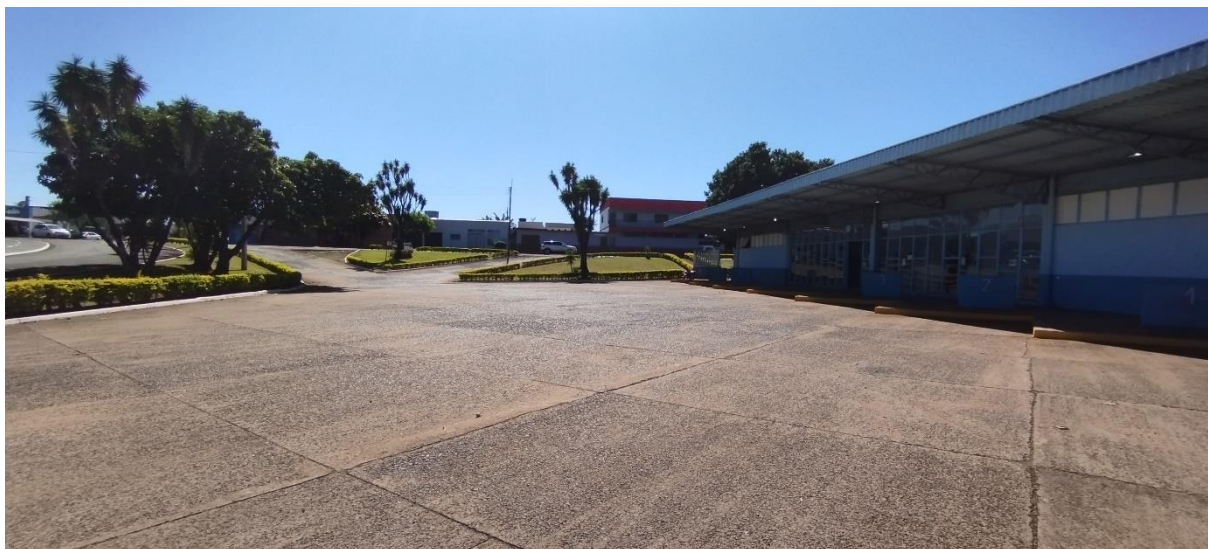
Figura 2.14. Terminal Rodoviário de Santa Tereza do Oeste-PR.
