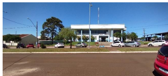
Figura 2.8. Acesso ao Paço Municipal.
